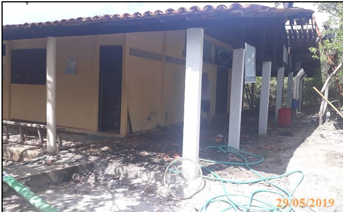
Figura 24: Centro de visitantes no início das obras.
