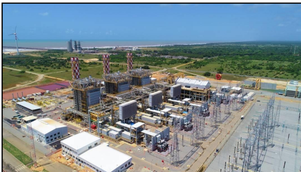
Figura 101: Vista aérea da Centrais Elétrica de Sergipe no município de Barra dos Coqueiros, Sergipe. Fonte: Google.
