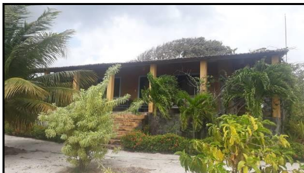
Figura 10: Vista externa do imóvel
