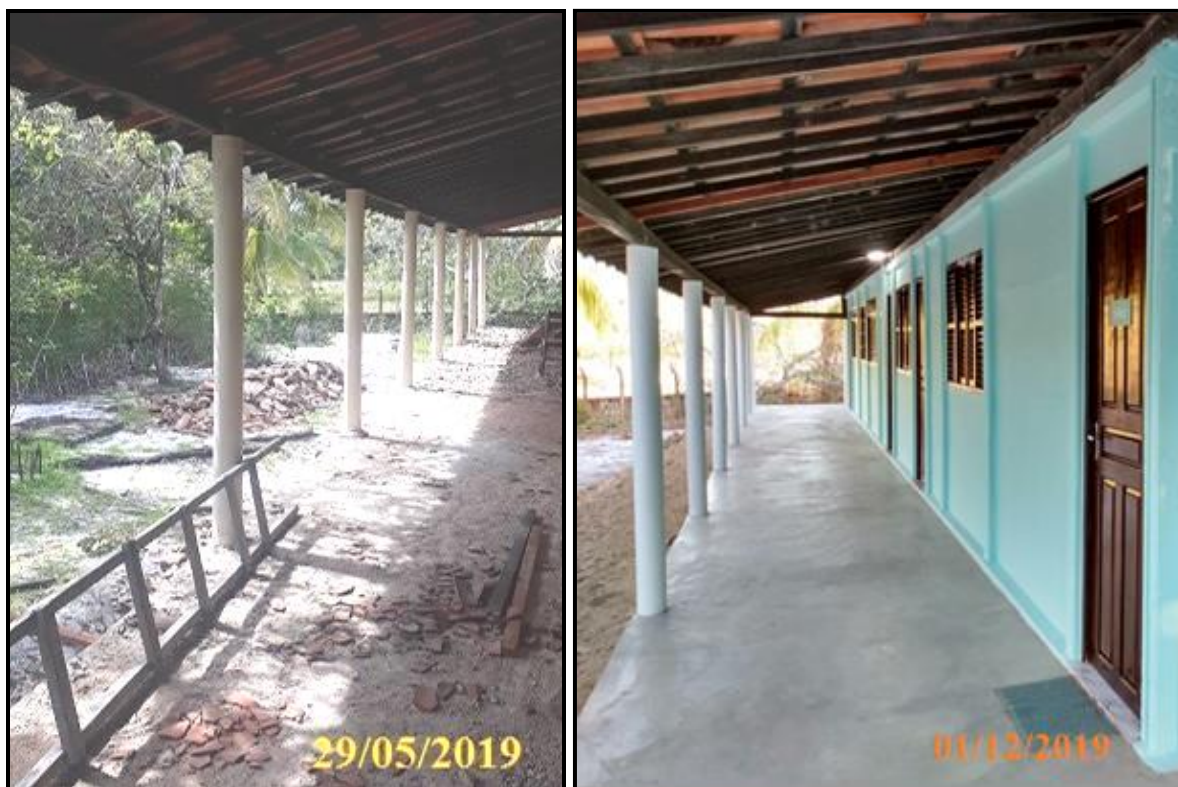
Figuras 20 e 21: Substituição das colunas de sustentação, reforma do piso e telhado, pintura externa e pintura de portas e janelas.
