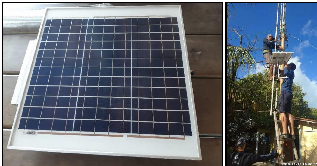
Figuras 98 e 99: Instalação do painel solar do gateway .
