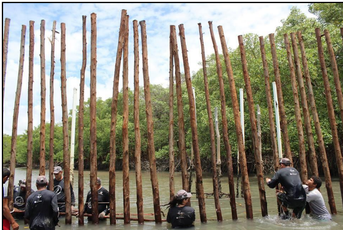
Figura 30: Construção do cativeiro de readaptação por colaboradores da FMA e APA da Barra do Rio Mamanguape.
