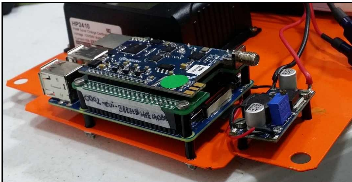
Figura 96: Posicionamento das placas eletrônicas com espaçadores no gateway.
