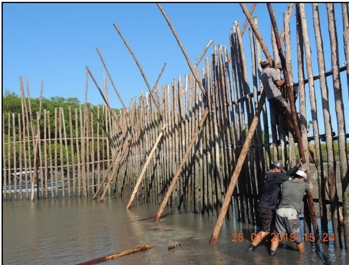
Figura 53: Construção do recinto de readaptação dos peixes-bois marinhos na Paraíba.
