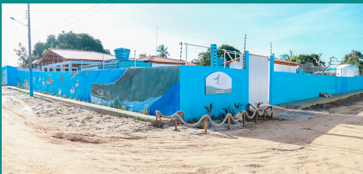
BASE SERGIPE - CENTRO DE DESPETROLIZAÇÃO E REABILITAÇÃO DE FAUNA MARINHA
