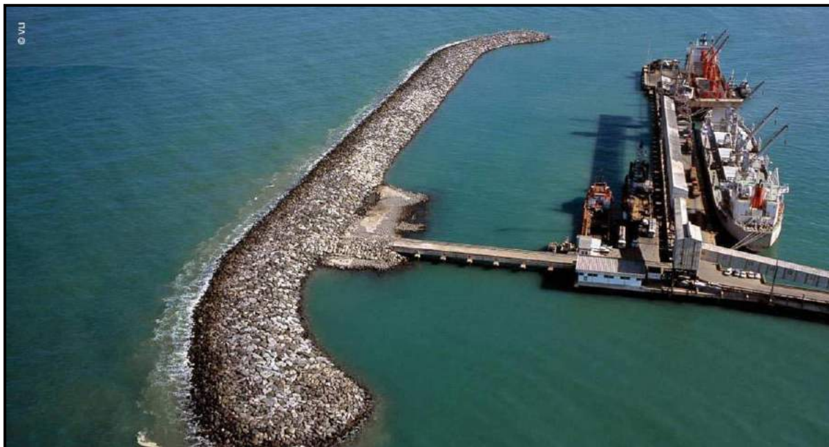
Figura 41: Terminal Hidroviário Inácio Barbosa (TMIB) localizado no povoado Jatobá, município de Barra dos Coqueiros, Sergipe.
