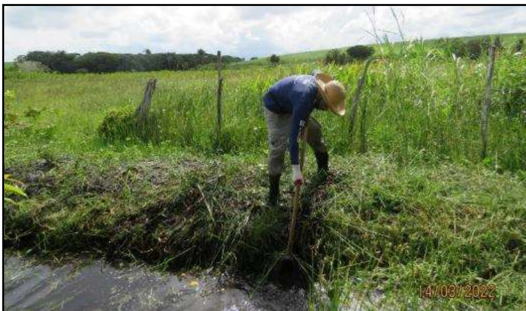
Figura 1.2.4.17: Retirada da vegetação reptante e sedimento do interior e margem do riacho.
