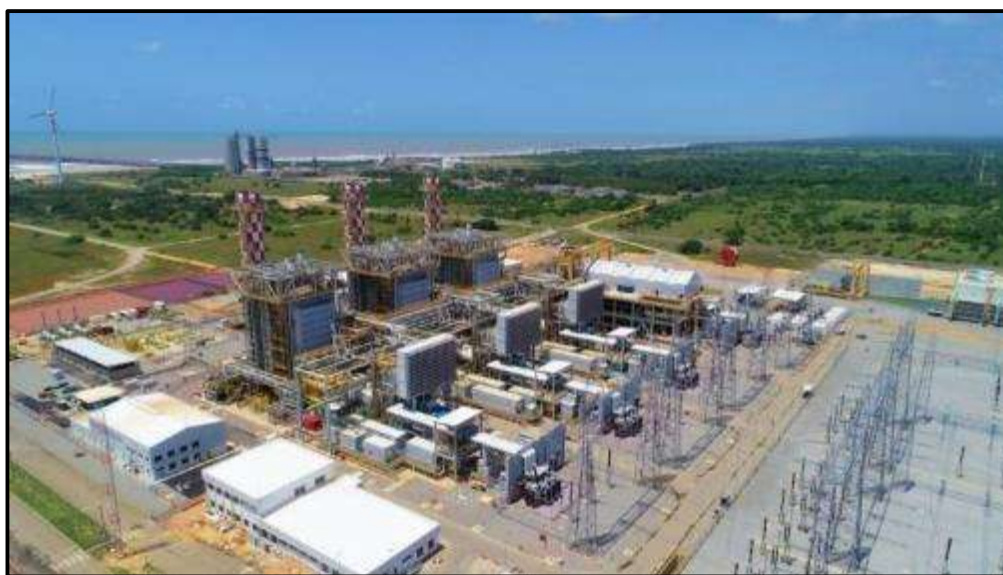
Figura 2.6.1: Centrais Elétricas de Sergipe (CELSE) localizada no povoado Jatobá, município de Barra dos Coqueiros, Sergipe. Fonte: Google.
