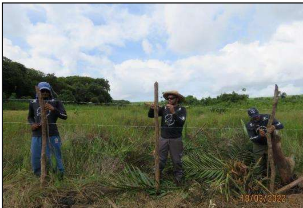
Figura 1.2.4.19: Construção da cerca de proteção.
